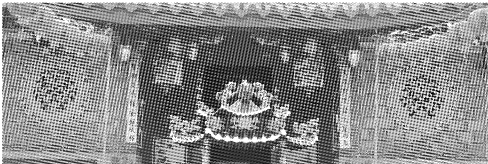
图12 修复后的正面外墙墙面（刘国棋拍摄）
